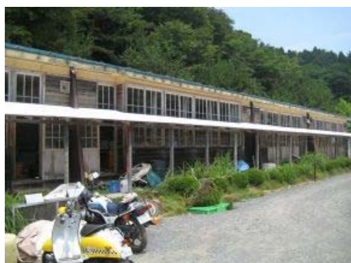
大きな荷物の運び先として利用された校舎
