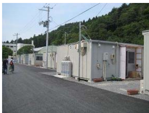
体育館横の仮設住宅
